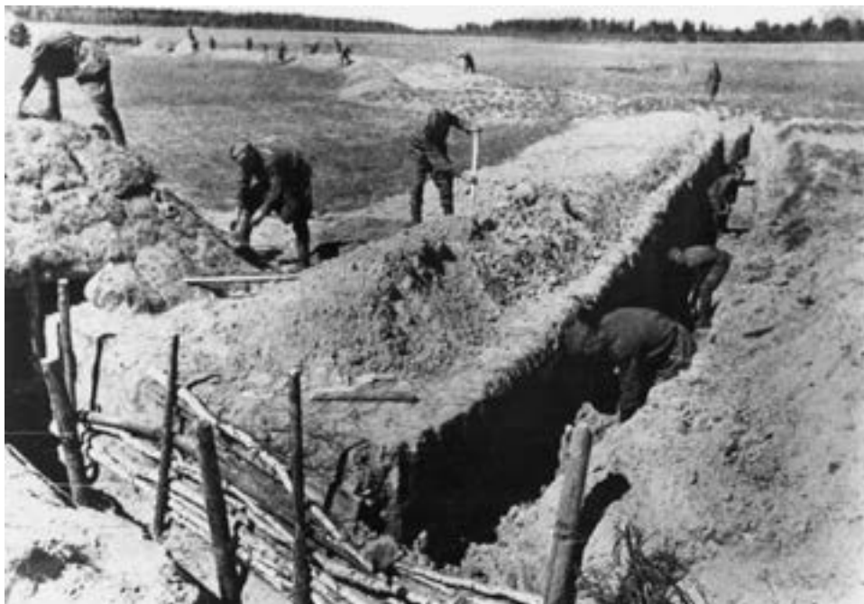
Строительство оборонительных сооружений на Курской дуге
