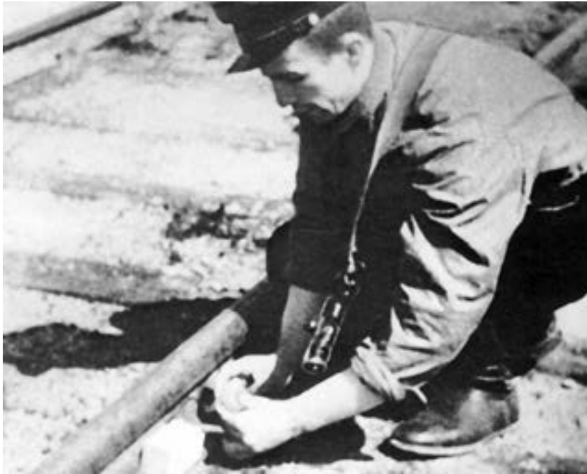
Подготовка к подрыву железнодорожного полотна
