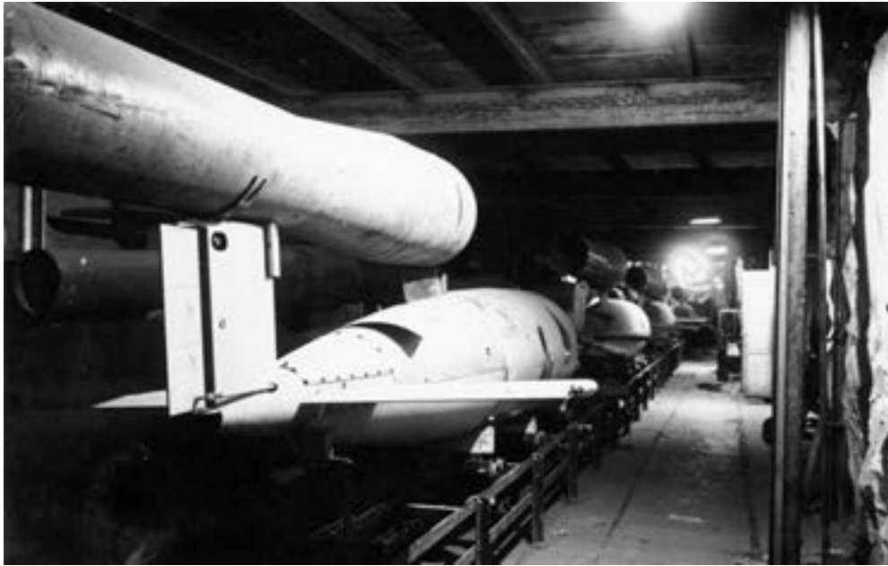
Производство ракет Фау-1 на подземном заводе в Германии
