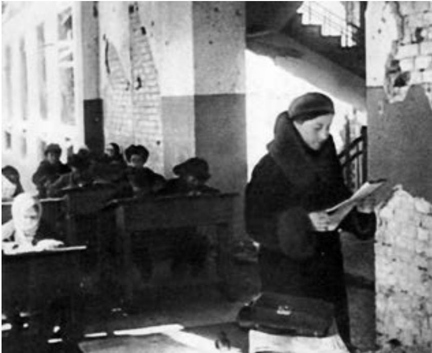
Школа восстановлена еще не полностью, но дети уже приступили к учебе. г. Сталинград
