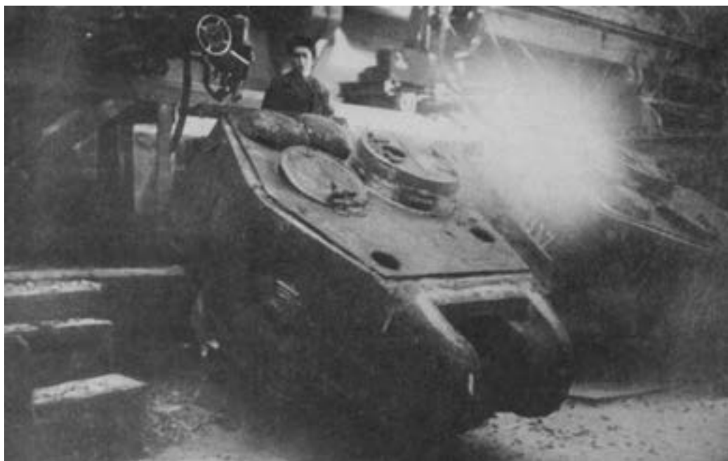
Автоматическая приварка крыши к литой бронебашне танка Т-34-85
