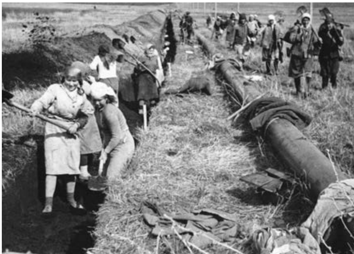
Советские женщины на строительстве газопровода Саратов — Москва
