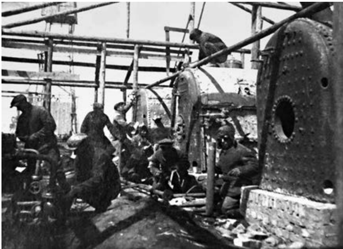
Разборка оборудования завода для последующей эвакуации в тыл
