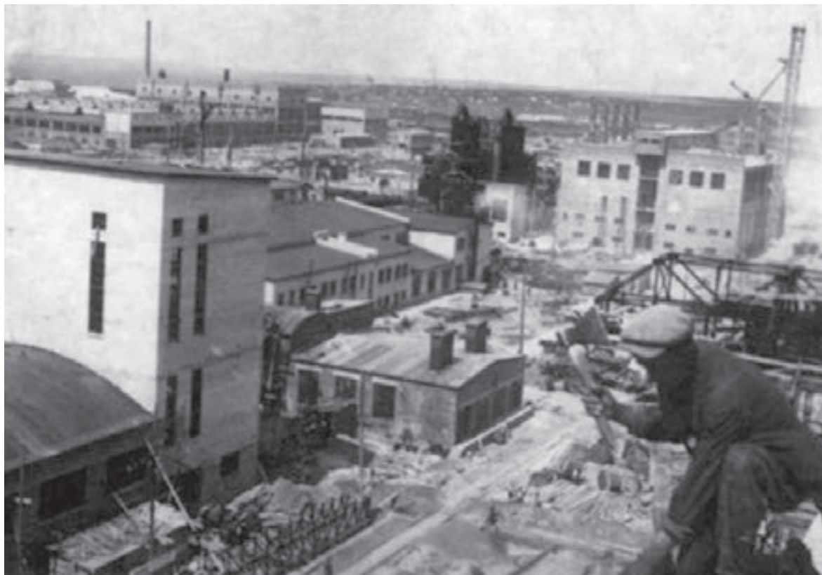
Восстановление завода в Запорожье
