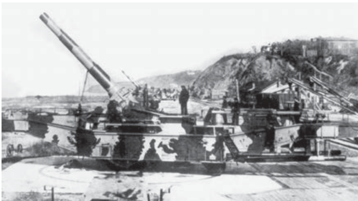
305-мм артиллерийская установка ТМ-2-12
