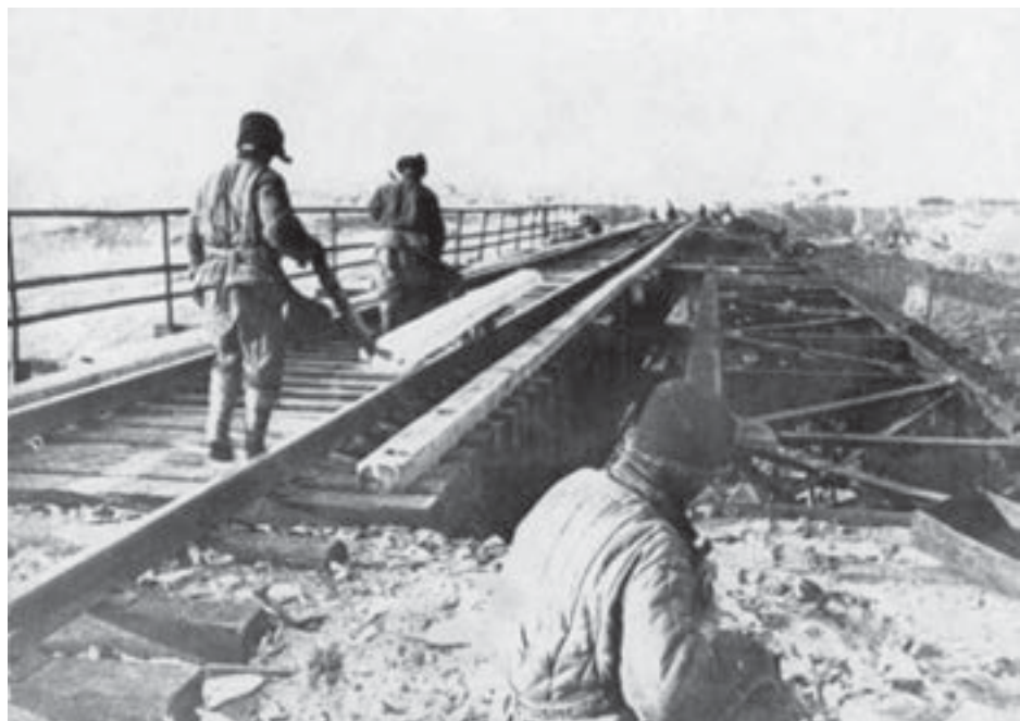
Восстановление железнодорожного моста
