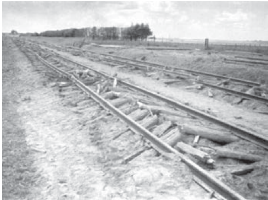
Железнодорожное полотно, разрушенное отступающими немецкими войсками
