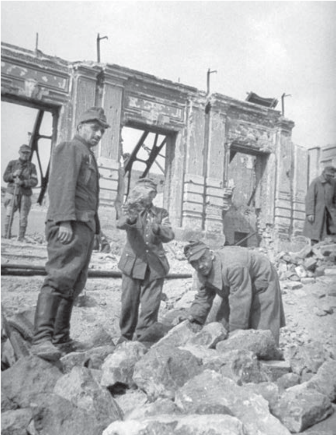
Немецкие военнопленные на работах по восстановлению Сталинграда
