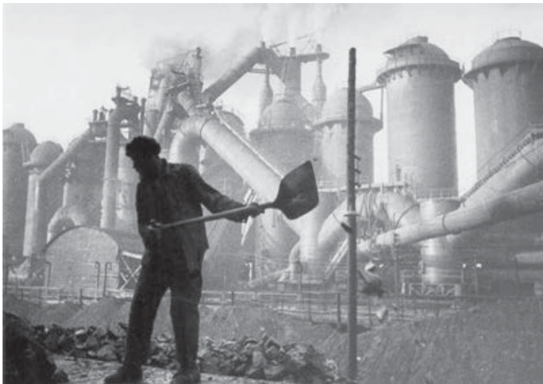
Строительство в Магнитогорске
