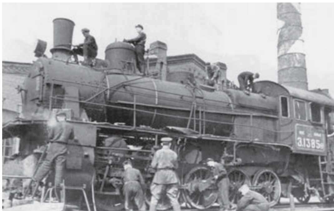
Ремонт поврежденного паровоза на путях Московской Окружной железной дороги
