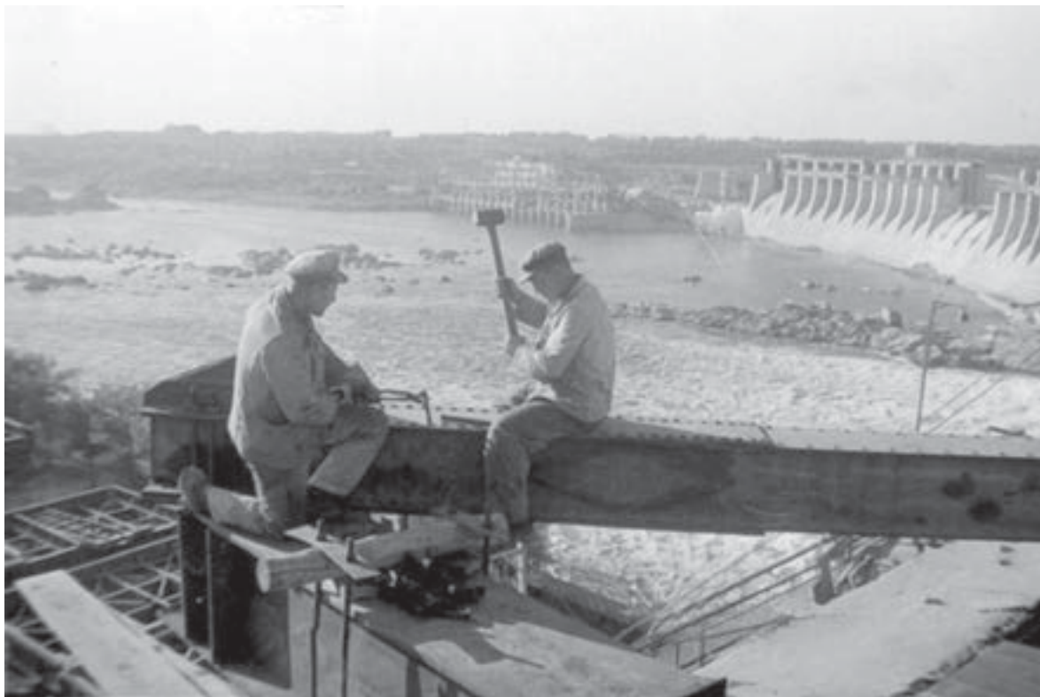
Работы по восстановлению Днепрогэса
