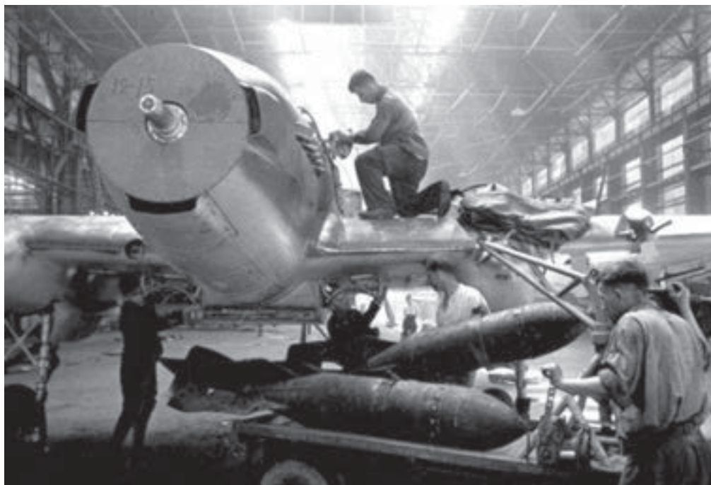
Подвеска испытательных бомб к самолету на самолетостроительном заводе № 18 им. К. Е. Ворошилова
