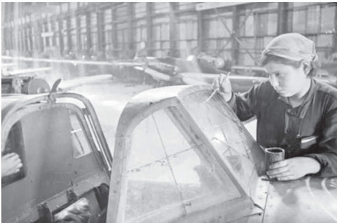
Участница Всесоюзного социалистического соревнования, ученица ремесленного училища, комсомолка А. Федченкова за отделкой бронестекла кабины летчика
