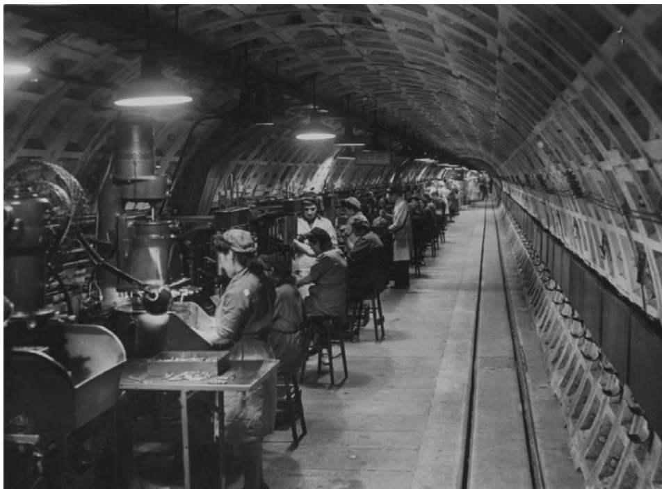
Работницы у станков завода в тоннеле метро центрального Лондона
