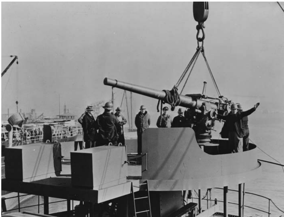
Установка корабельной пушки на борт грузового судна
