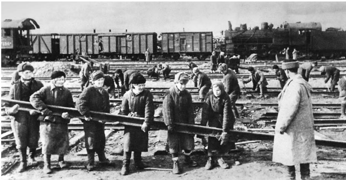
Ремонт железнодорожных путей после бомбежки
