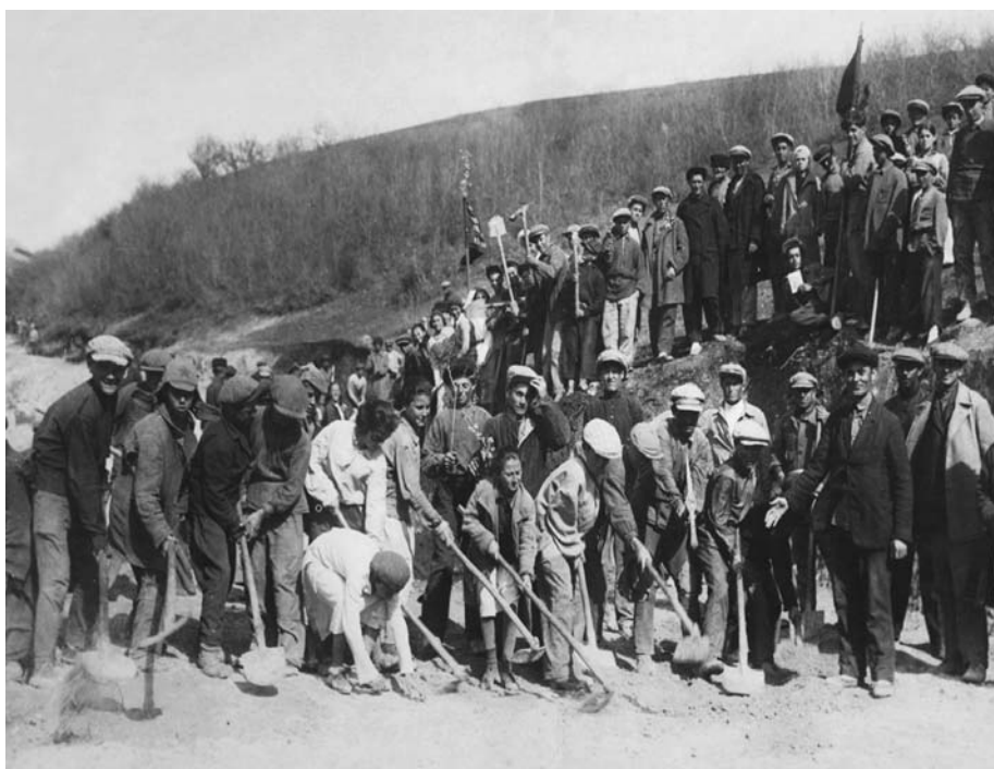
Комсомольцы за ремонтом дороги
