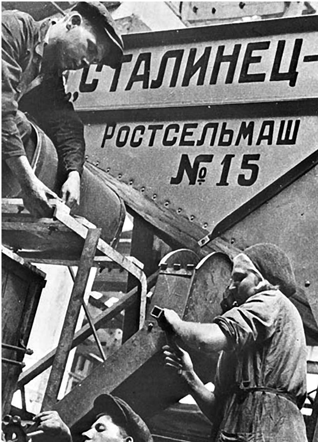
В заводском цеху
