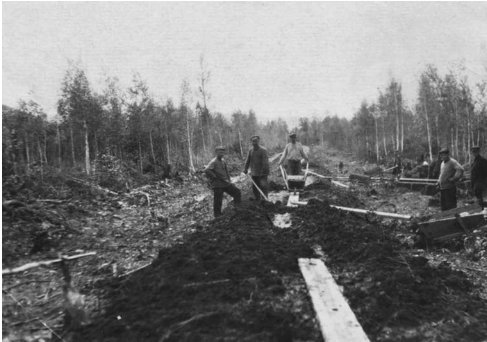
Строительство железнодорожной линии
