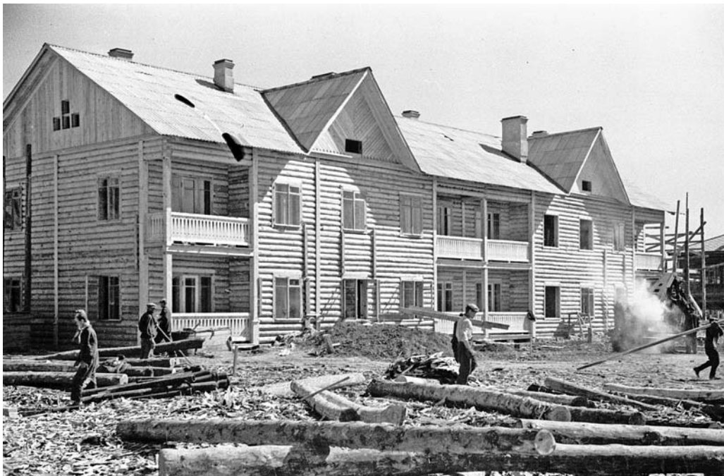
Строительство жилья для рабочих
